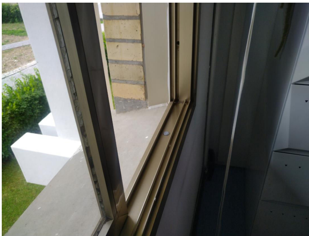
FOTO 2: TELAIO TIPO DEI SERRAMENTI ESISTENTI
